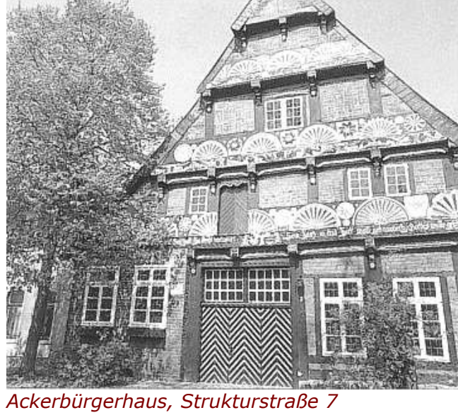
Ackerbürgerhaus, Strukturstraße 7 Pferdekundliche Bibliothek
